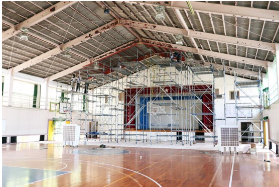
体育館天井の梁の改修工事の様子
